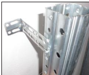
Geeignete Montageposition von Doppelregalverbinder
